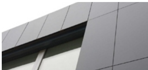
Внешняя облицовка зданий и сооружений (вентилируемые фасады)
